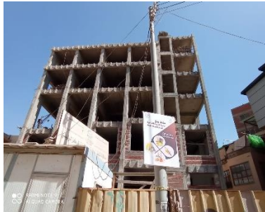
مبنى (٥) تحت الانشاء
