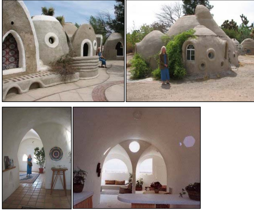
الشكل (5): منزل مشيد بأكياس الرمل ويظهر طابعه المعماري المتميز بالخارج والداخل. المصدر: [10]
