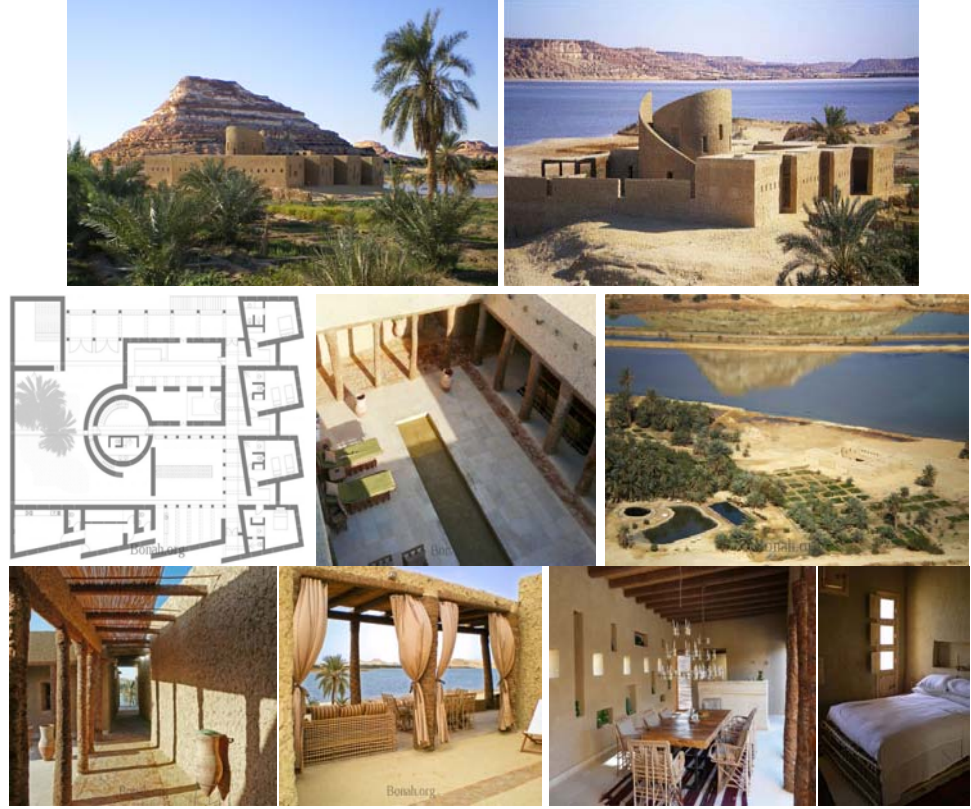
الشكل (14): منتجج Eco-Lodge بسيوه – مصر 2004–2007. المصدر: [16]
