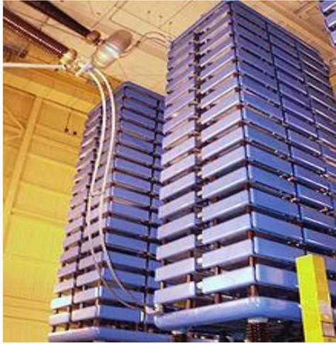
الشكل (٤ - ١٨) قاعة صمامات الثايرستور المستخدمة لنقل الكهرباء لمسافات طويلة
