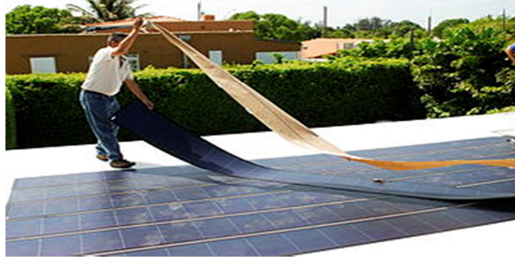
الشكل (٧-٢٠) رقائق السليكون بتكنولوجيا الأغشية أو الأفلام الرقيقة يتم تثبيتها على الأسطح
