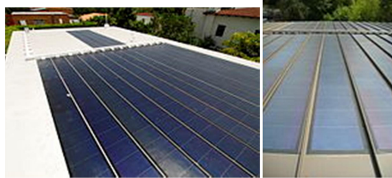
الشكل (٧-٢٢) خلايا شمسية ذات طبقة رقيقة من مواد لتجميع حرارة الشمس على أسطح المنازل
